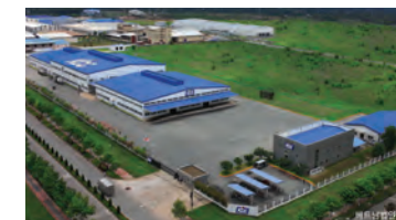
베트남 호치민법인 건축도로, 선박도로, 플랜트도로, 자동차도로, 일반공업도로, PCM도로
